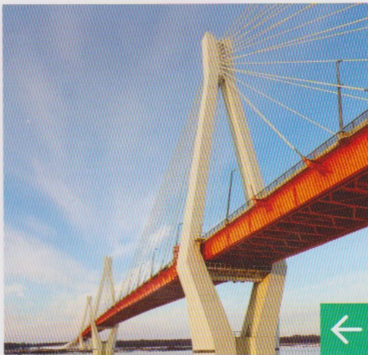
รูป 4.2 สะพานแขวนที่ต้องการโครงสร้างที่ยืดหยุ่นและรับแรงดึงได้ดี
